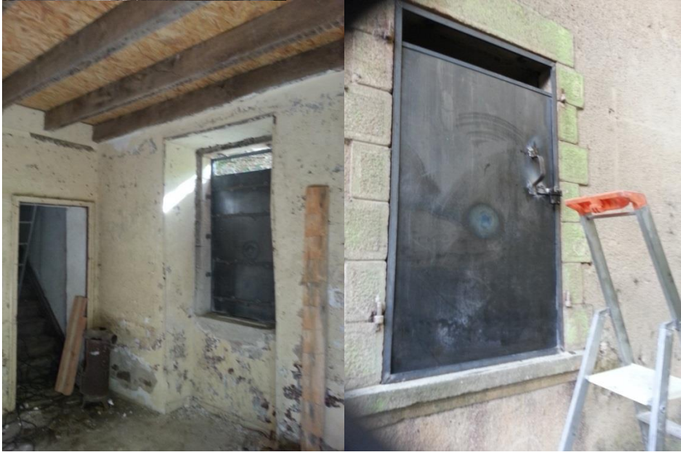
Fermeture amovible d'une fenêtre pour accéder au bâtiment
