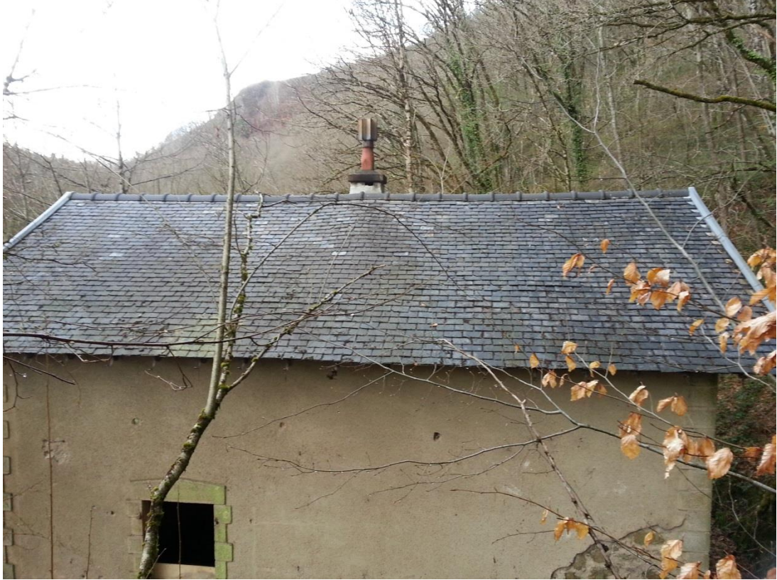
Façade Sud avant et après travaux
