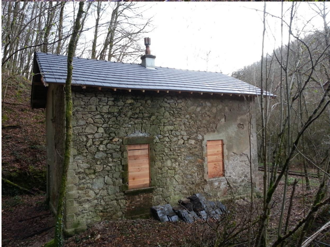
Façade Nord avant et après travaux
