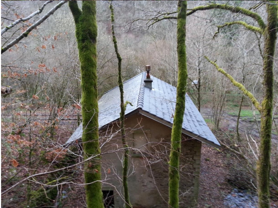
Façade Est avant/après travaux
