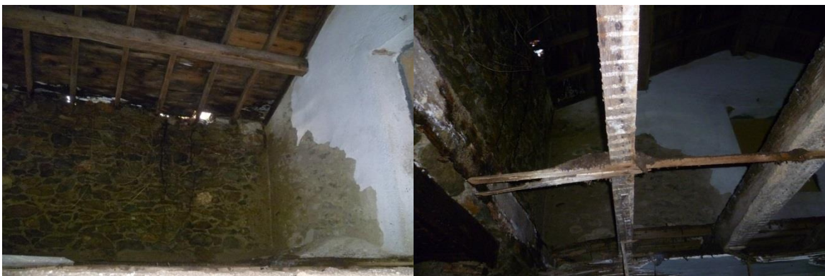
Etat de la toiture et de l'intérieur du bâtiment sur la façade Nord
