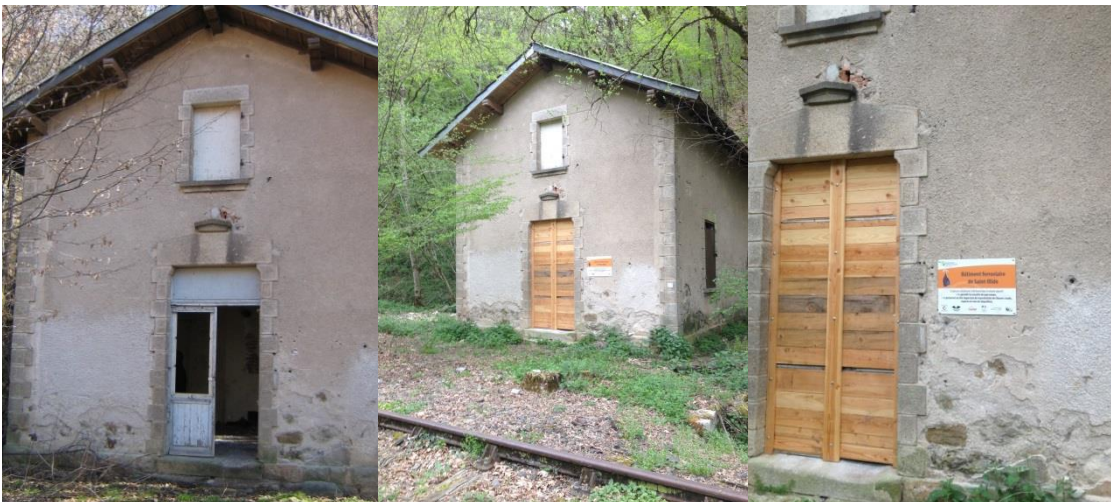
Condamnation de la porte et pose d'un panneau d'information
