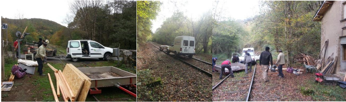
Apport des matériaux et du matériel : 1,4 km pour accéder au bâtiment
