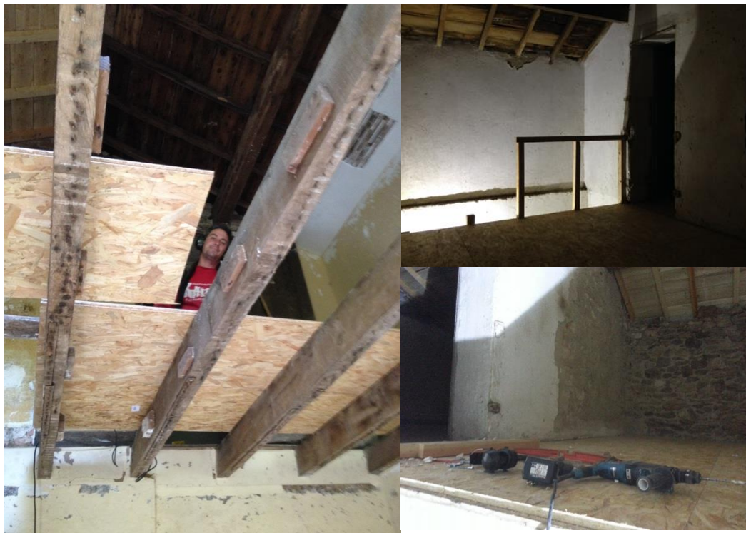
Pose d'un plancher en OSB à l'étage pour cantonner les colonies de chauves-souris
