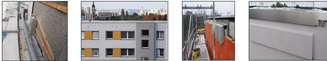
Exemples d'intégration de nichoirs dans la maçonnerie (Sources : Photos 1, 2, 3 : Bund für Umwelt und Naturschutz Deutschland, Photos 4 et 5 : Apus & Nyctalus, Peter Bačkor, Photos : 6, 7, 8 et 9 : Thomas Frank)
