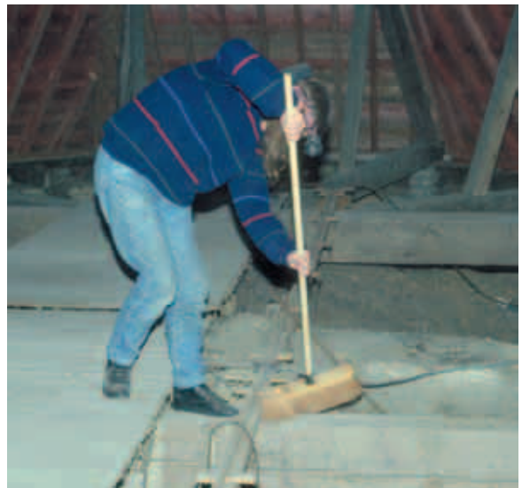
Un nettoyage des principales surfaces planes des combles et du clocher permet d'affiner les observations futures (J. Fairon - CRC)
