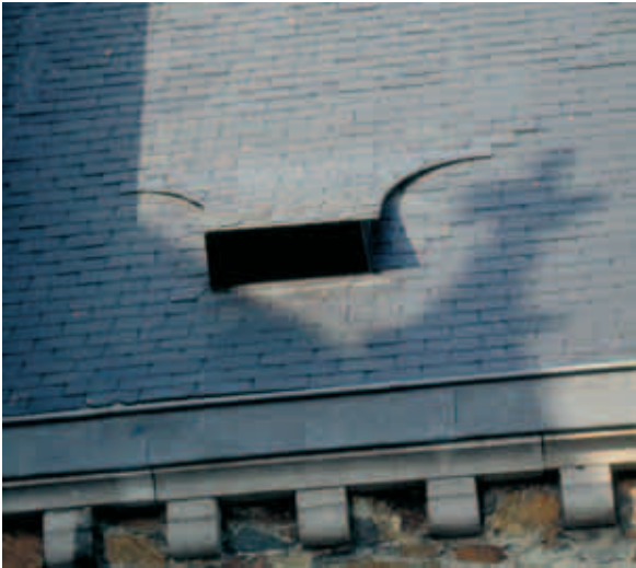
Chiroptière de l'église de Hennuyères exécutée à l'initiative de la commune de Braine-le-Comte (J. Fairon)
