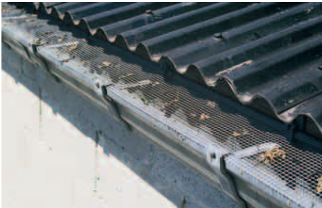
Pour éviter l'accumulation de branchettes dans les gouttières à l'aplomb des entrées de nids, il est parfois utile de protéger celles-ci par un grillage rigide (S. Lamotte)
