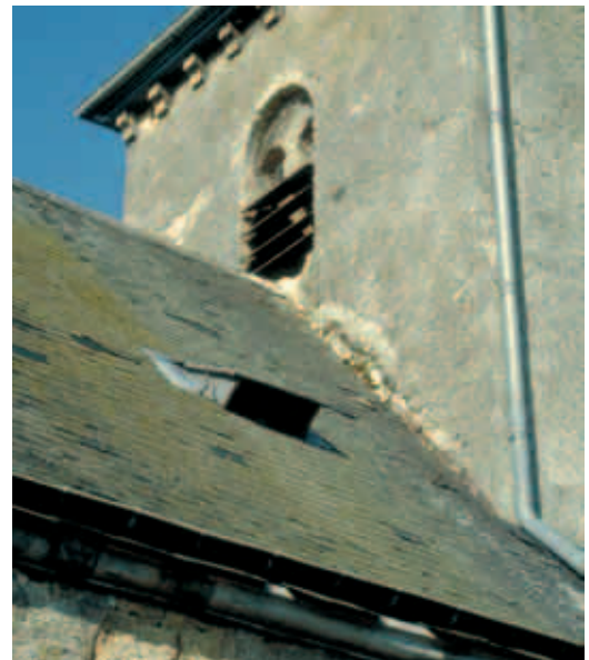
Prototype de chiroptière réalisé sur le toit de l'église de Metzert - Luxembourg (J. Fairon)
