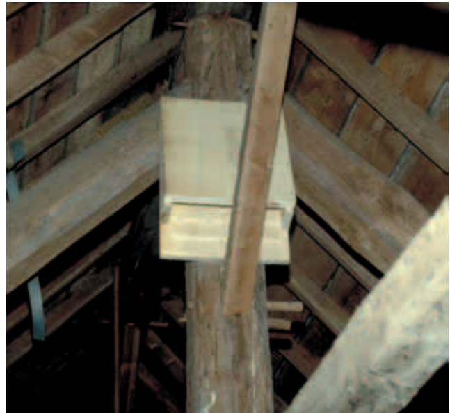
Microgîte de type évasé, dans les combles d'une église (J. Fairon)
