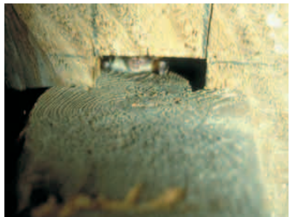
Oreillard dans un trou de mortaise de fixation - poinçon et arbalétrier (J. Fairon)
