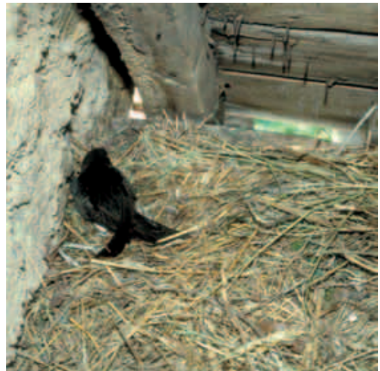
Nid de martinets sur le mur porteur dans les combles d'une église (J. Fairon)
