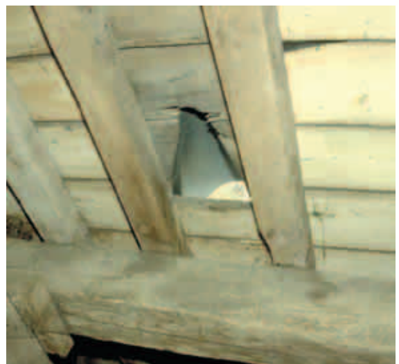
Chatière aménagée dans une toiture (J. Fairon)
