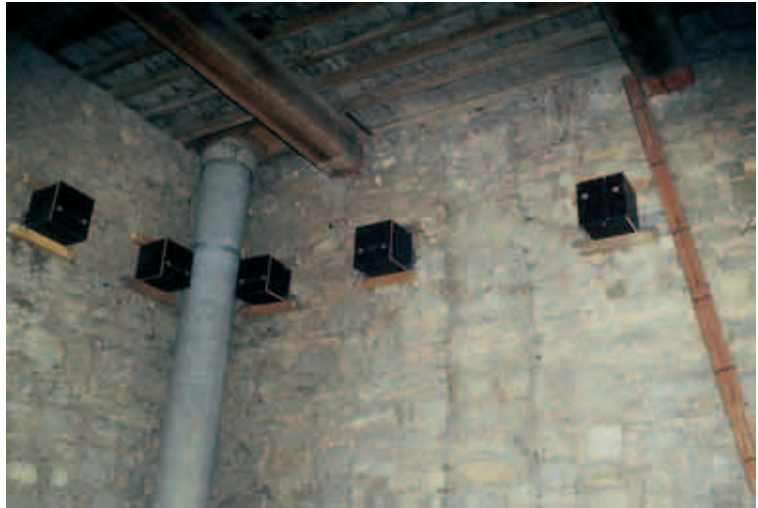
Batterie de nichoirs sur trous de boulin dans une tour d'église (J. Fairon)
