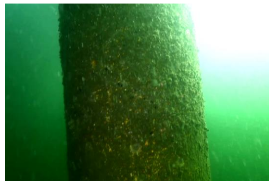
Pieu non équipé
