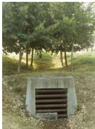
Photo 4 Grille en début du tunnel
