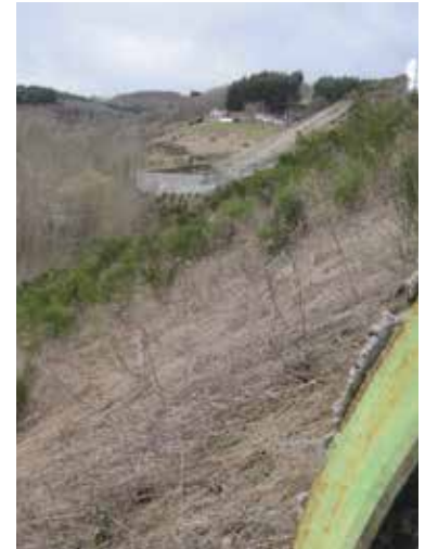
Vue du talus de l'A89 depuis l'entrée de la galerie du Boussuivre en cours de recolonisation par la végétation (février 2017).
