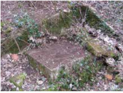
Dalle béton obturant le puits d'entrée avant le chantier
