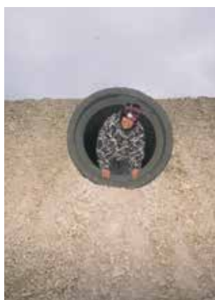
Sortie du tunnel après l'aménagement
