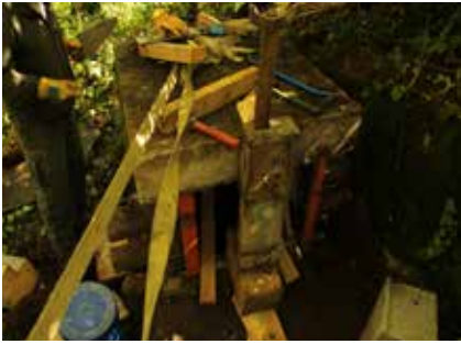
Dalle béton obturant le puits d'entrée avant le chantier
