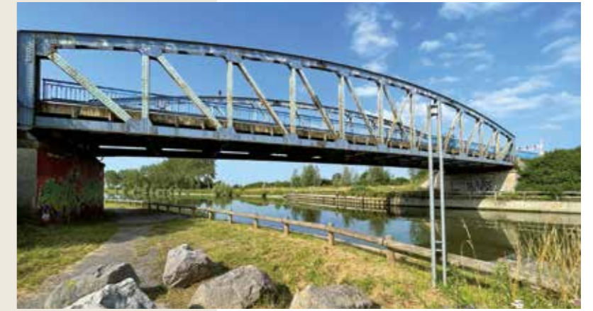
Pont routier sur le canal de l'Aa, un des points stratégiques pour l'étude et le suivi du Murin des marais. - V. Cohez-CMNF
