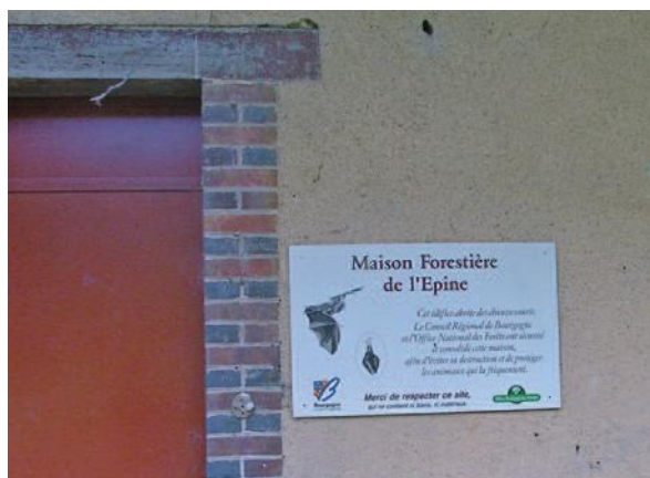
Assurer la quiétude des lieux par la fermeture des ouvrants : maçonnerie des fenêtres, fixation des volets, porte métallique blindée. Maison forestière de l'Épine (Yonne). © Christophe Bréant et Christophe Mouy/ONF
