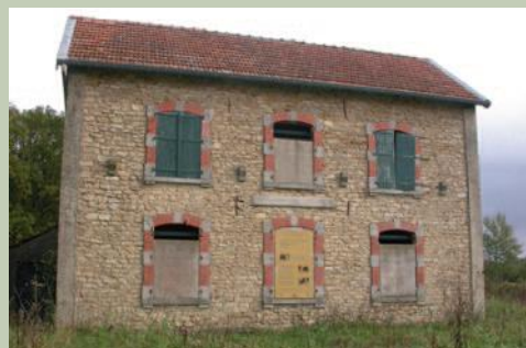
Les fenêtres ont été maçonnées pour empêcher le vandalisme. On notera qu'un espace a été conservé ouvert en haut de certaines. L'idée est ici de permettre aux oiseaux de nicher entre cette maçonnerie et les fenêtres - maison forestière de Boucq (Meurthe-et-Moselle). © François Schwaab.
