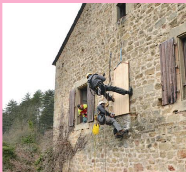
Un faux volet légèrement décollé du mur a été posé afin de pérenniser la colonie de Barbastelle d'Europe découverte derrière les volets précaires du bâtiment - maison forestière de Saint Sauveur des Pourcils (Gard). © Olivier Vinet/ONF.
