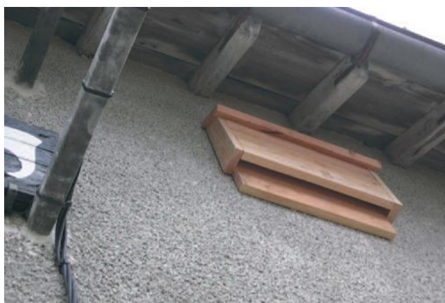
Poser des nichours plats en bois sur chacune des 4 façades d'un bâtiment permet d'augmenter les capacités et la diversité d'accueil pour les chauves-souris - Maison forestière de Jugny (Côte d'Or). © Frédéric Malgouyres/ONF.
