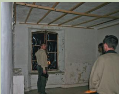
Deux aménagements peu coûteux mais très efficaces : la pose de lattes au plafond afin d'offrir de meilleurs supports d'accroche pour les chauves-souris et la pose de bâches noires sur les fenêtres afin d'occulter la lumière - maison forestière de Boucq (Meurthe-et-Moselle). © Frédéric Malgouyres/ONF
