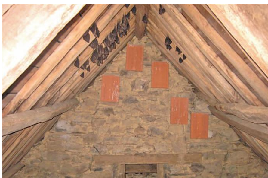
Quelques briques patrières posées contre un mur augmentent les capacités d'accueil pour les chauves-souris comme d'autres espèces cibles. Maison forestière de la Roche noire (Finistère). © Guy Le Reste/ONF
