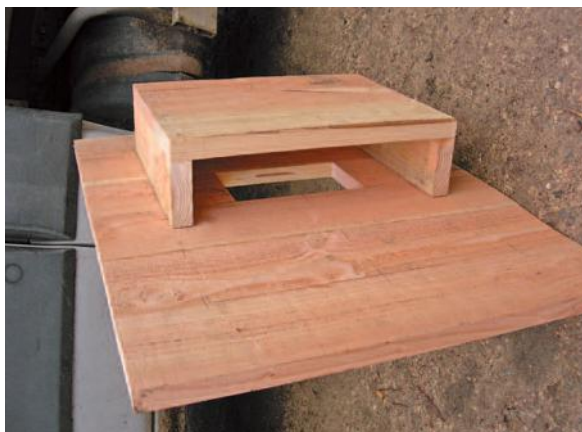
La chicane d'une chiroptière permet l'entrée des chauves-souris tout en évitant celle de ses prédateurs. L'ouverture rectangulaire sera bien entendue disposée à l'horizontale. © Frédéric Malgouyres/ONF.
