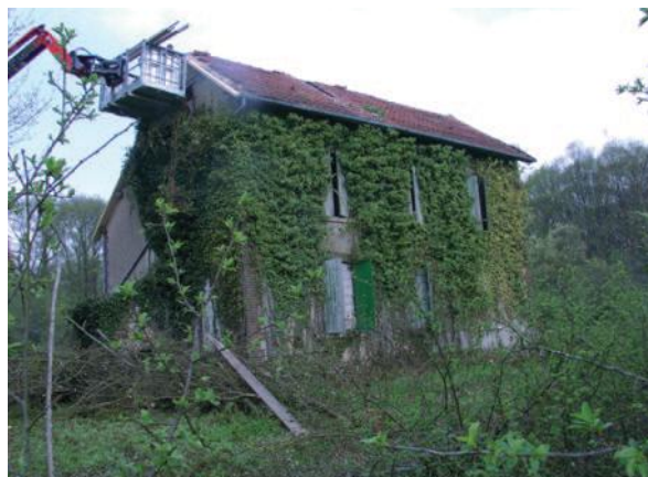
Toujours débiter les travaux par la mise hors d'eau du bâtiment, seul moyen de garantir sa pérennité. Maison forestière de l'Épine (Yonne). © Christophe Bréant et Christophe Mouy/ONF
