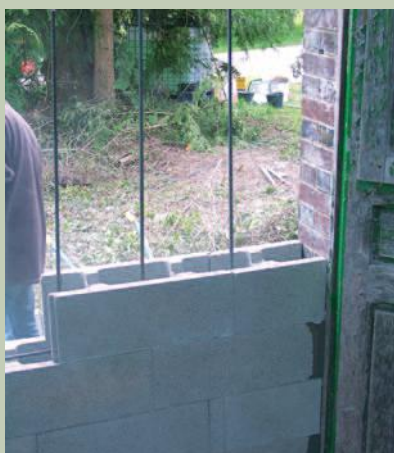
Dans le cas de fort risque de vandalisme, les maçonneries seront armées pour clore les ouvertures inutilisées - maison forestière de l'Épine (Yonne). © Christophe Mouy et Christophe Bréant/ONF.
