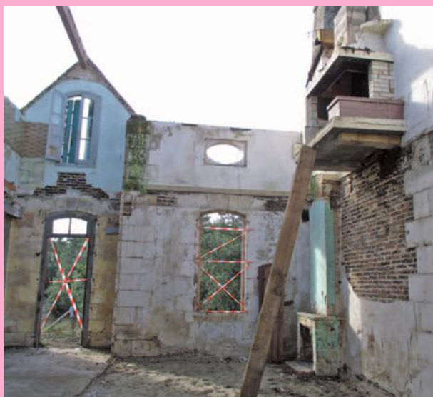
Le bâtiment était délabré, dangereux, mais il s'agissait d'un élément patrimonial local à préserver - maison forestière de Passe Blanche (Charente-Maritime). © Serge Chaigneau/ONF
