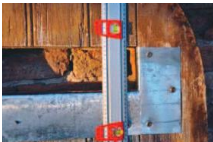
Chiroptière en métal ou entrée « boîte à lettre » recouverte de zinc. (Source : LIFE+ Chiro Med, 2014)
