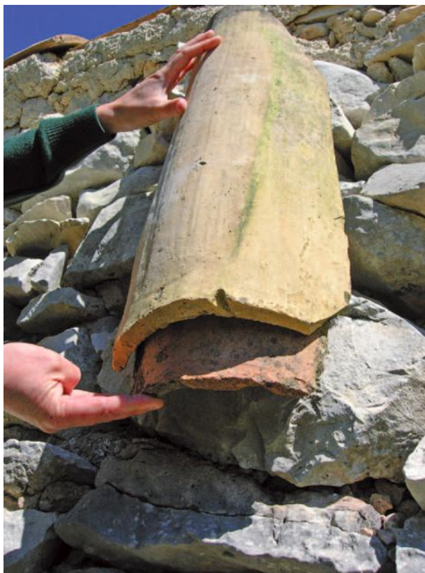
Une autre version du nichoir de façade : maçonner des tuiles canal ensemble, par 2 (ou plus). Veiller à décaler chaque tuile en hauteur pour permettre "l'atterrissage" des chauves-souris. Laisser un espace de 3 cm à l'entrée et 1 cm en haut (comme les nichoirs en bois) - forêt domaniale du Ventoux (Vaucluse). © Frédéric Malgouyres/ONF
