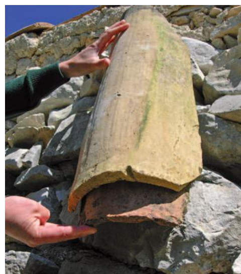
Nichour en tuiles canales de récupération. © Frédéric Malgouyres/ONF.
