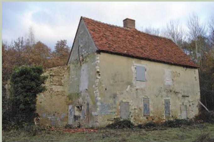
Lors d'une mise en sécurité de bâtiment, le plus simple est souvent de murer les ouvertures. Mais attention à maintenir une (des) ouverture(s) de passage pour la faune et une porte d'accès (blindée en fer) permettant d'effectuer visites de contrôle ou comptages - prieuré de Bléron (Cher). © Thierry Gautrot/ONF.
