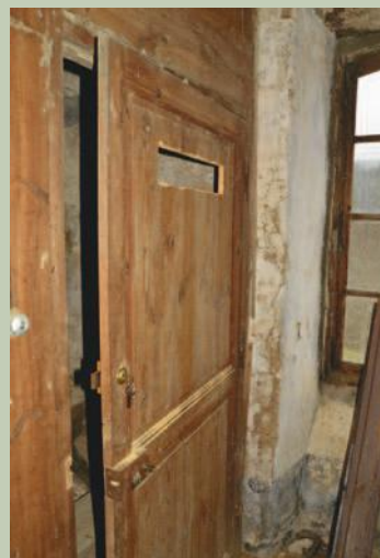
Ménager une ouverture en haut des portes intérieures permet la circulation des chauves-souris tout en limitant les risques de courants d'air - maison forestière de Saint Sauveur des Pourcils (Gard). © Olivier Vinet/ONF.
