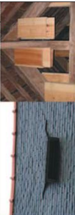
Ouverture pour les chauves-souris dans une toiture
