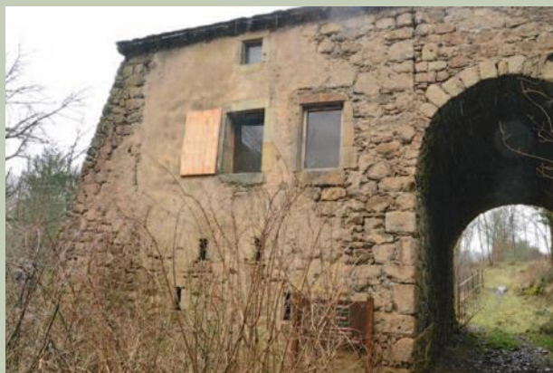
Comme pour des nichoirs, l'utilisation de planches de Douglas non traitées (bois naturellement durable) pour ce faux volet évite tout risque d'intoxication des animaux par contact - maison forestière de la Boissière (Gard). © Olivier Vinet/ONF.
