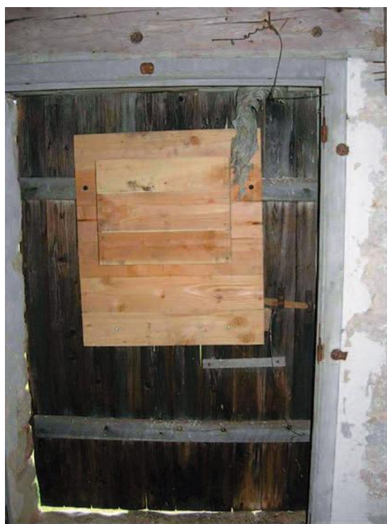
Chiroptière vissée au volet du grenier. © Frédéric Malgouyres/ONF
