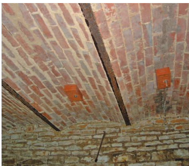
Dans une cave, dont les conditions sont plus humides, on privilégiera la fixation de briques creuses au plafond et/ou contre les murs - maison forestière des Suchaux (Côte d'Or). © Frédéric Malgouyres, ONF
