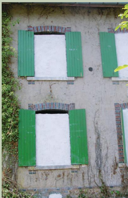
Il est important de ménager des passages en partie supérieure des fenêtres maçonnées pour permettre l'entrée de la faune volante - maison forestière de l'Épine (Yonne). © Christophe Mouy et Christophe Bréant/ONF.
