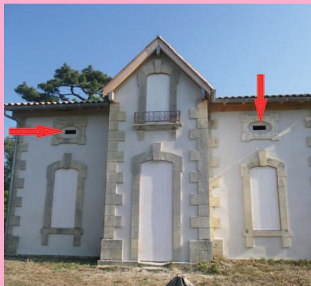
Sous le niveau des toits, des chiroptières rectangulaires permettent aux chauves-souris de pénétrer dans le bâtiment, tout en limitant la prédation - maison forestière de Passe Blanche (Charente-Maritime). © Serge Chaigneau/ONF
