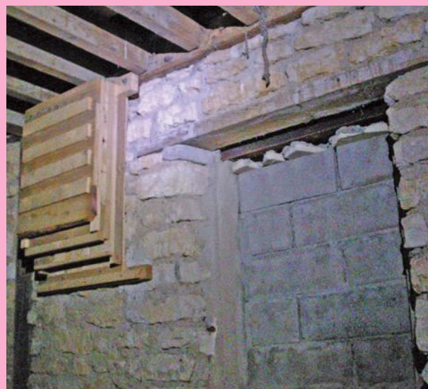
Un nichoir multicouches, offrant des interstices d'épaisseurs différentes, permet à chaque espèce de chauve-souris d'y trouver son bonheur - maison forestière de Boucq (Meurthe-et-Moselle). © François Schwaab.
