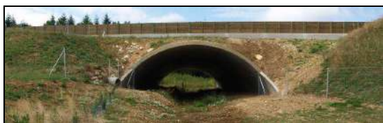
Ouvrage inférieur de l'autoroute A88 équipé d'un écran d'occultation (Source : Groupe mammologique Normand)
