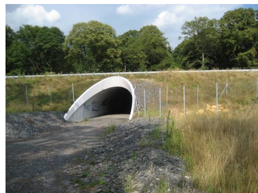
Exemple d'ouvrage inférieur suivi pour les chauves-souris lors des campagnes 2010 et 2011
