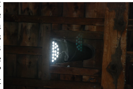
Cathédrale de Montauban : ouverture d'aération utilisée pour créer un accès aux combles pour les chauves-souris
