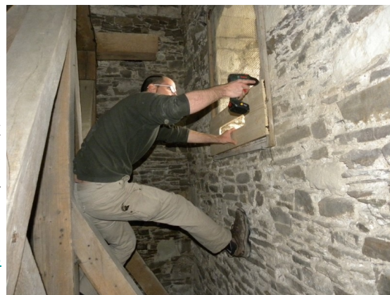
Installation de la chiroptière © Nicolas Chenaval
