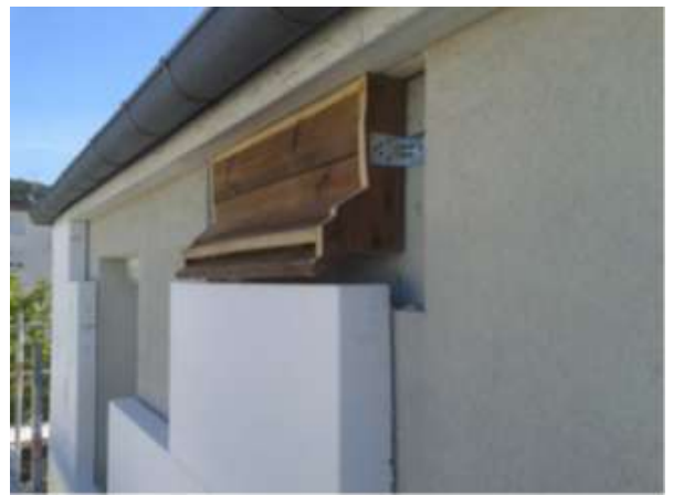
Pose d'un gîte en bois intégré dans l'isolant
