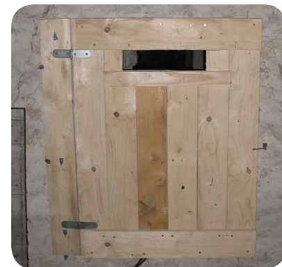
L'installation d'une porte en bois (pouvant d'un passage pour les chiroptères) entre les combles et le clocher présente plusieurs intérêts : cela diminue la luminosité dans les combles et limite les dérangements pour les chauves-souris (porte fermée à clé et panneau d'information installé sur la porte).
