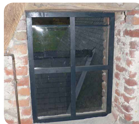
Sur cette église classée aux Monuments historiques, une ancienne fenêtre située dans les combles et donnant sur le pignon arrière a été reconstituée à l'identique. La surface vitrée laisse un accès de 6 cm de haut pour les chauves-souris.
