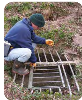
Grille posée à l'entrée d'une ancienne carrière de craie de près de 400 ans, avec un puits d'accès vertical et les chambres de craie à la base.
