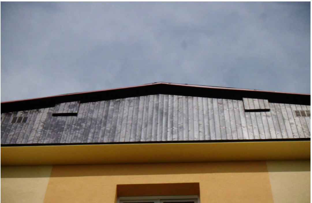
Figure 20. Utilisation des gîtes artificiels en bois sur la façade d'une école rénovée thermiquement. Avec l'aimable autorisation d'Evžen Tošenovský.
