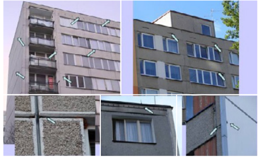
Figure 3. Exemples de gîtes de chauves-souris dans des immeubles d'habitation non isolés (République tchèque). Avec l'aimable autorisation de ČESON.
