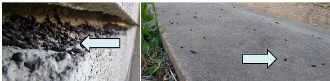
Figure 5. Guano entre les panneaux et sur le sol, à l'aplomb de la colonie de chauves-souris. Avec l'aimable autorisation de Martin Cel'uch.
