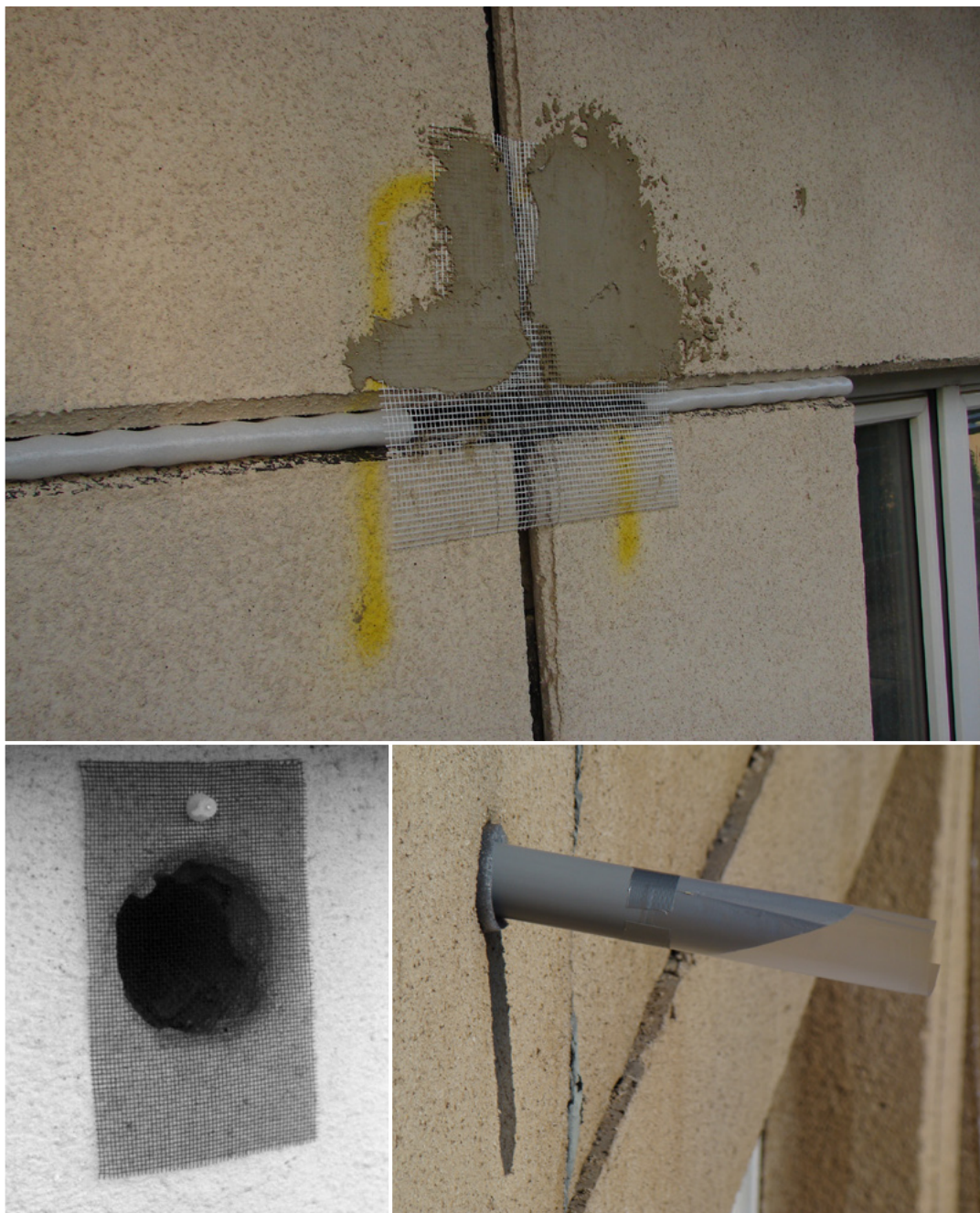
Figure 8. La trappe d'exclusion permet aux chauves-souris de quitter le gîte mais empêche leur retour. La trappe est fixée en haut et doit couvrir intégralement l'entrée et ne pas se détacher du mur. Un tube en plastique incliné d'au moins 4 cm de diamètre peut être utilisé à la place de la trappe d'exclusion. Un opercule en plastique empêche les chauves-souris et les martinets de pénétrer dans le tube. Avec l'aimable autorisation de ČESON et Martin Celuch.
