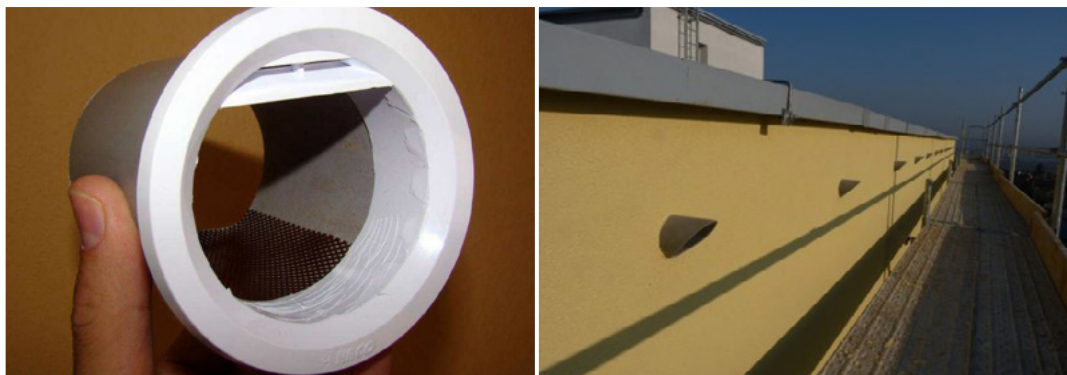
Figure 9. Couvertres des orifices de ventilation modifiés pour les chauves-souris et les martinets. Le diamètre minimum est de 6 cm. Avec l'aimable autorisation de Martin Ceľuch et Lukáš Viktora.
